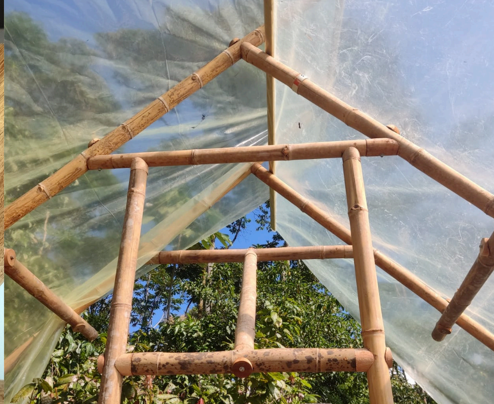
Foto No.25. Detalle de la implementación del sistema estructural AVECE en la construcción de un invernadero dentro de las instalaciones de la Universidad Ikiam.
