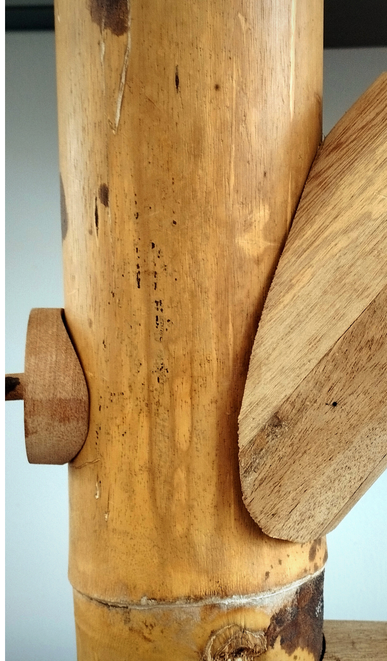
Foto No. 24. Maqueta que ilustra las diferentes tipologías de conexiones desarrolladas para el sistema AVECE en la Universidad Ikiam.
