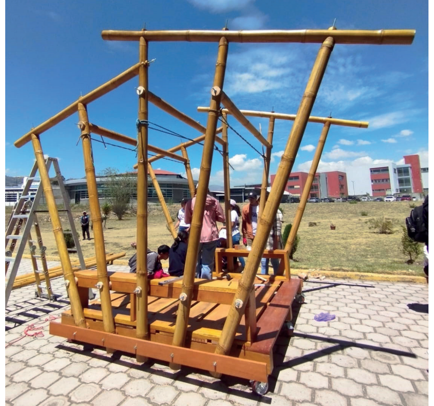
Foto No. 2. Montaje de prototipo estructural AVECE La imagen muestra el ensamblaje de un prototipo estructural con el sistema AVECE.
