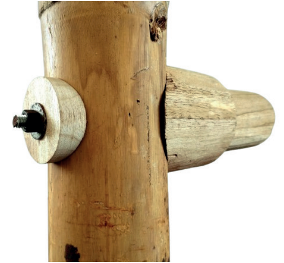
Aplicación de disco de contacto y taco de relleno
