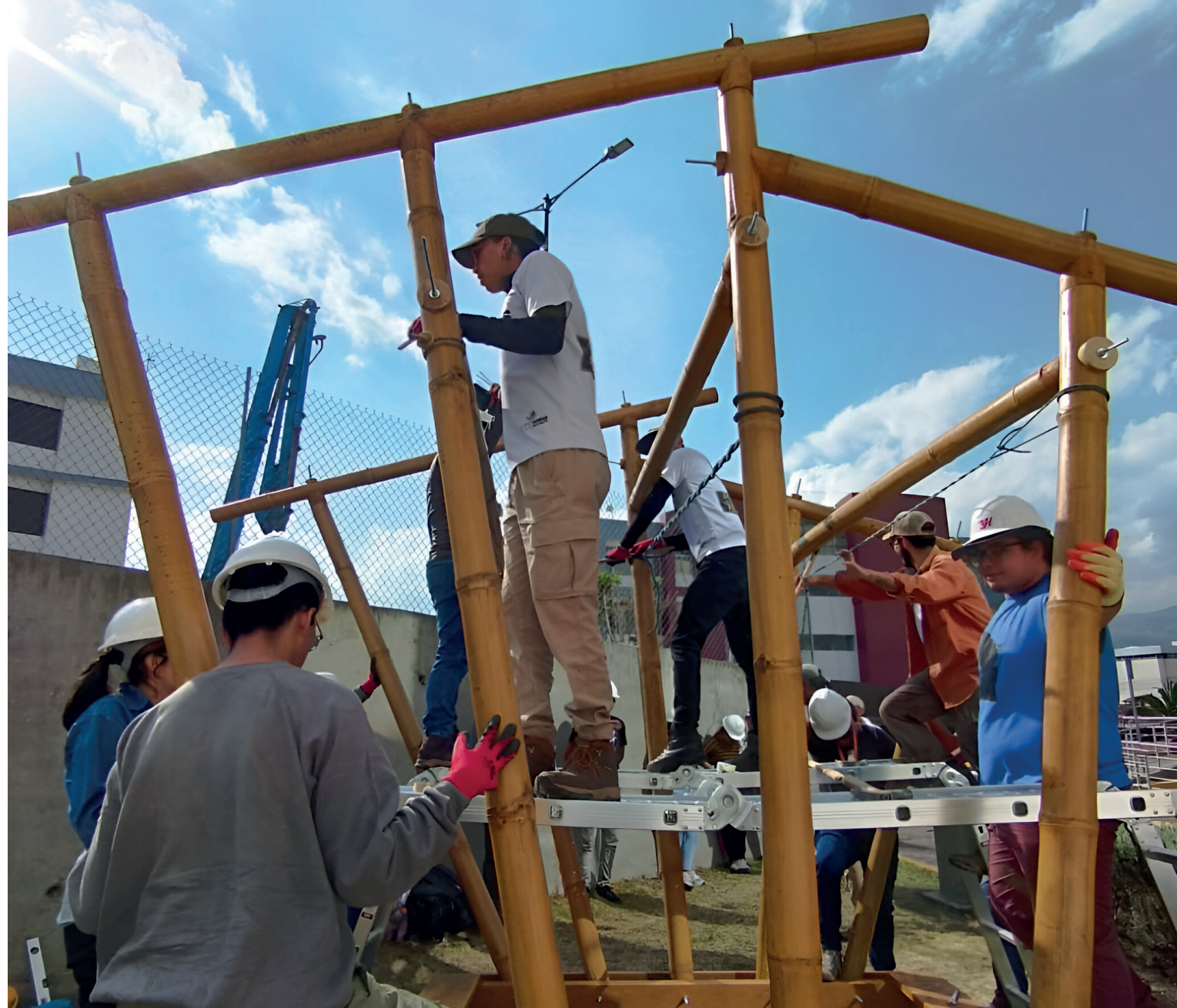
Foto No. 26 (pág. 49-50): Estudiantes y participantes del proyecto AVECE trabajando juntos en la construcción de una estructura de bambú durante un taller.
