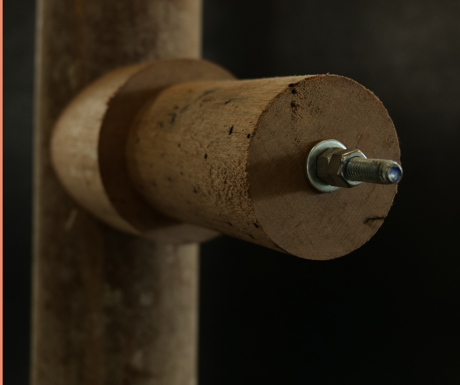
Foto No. 03 (pág. 07-08): Detalle del sistema de fijación del conector en bambú La imagen muestra en primer plano el detalle técnico del sistema de fijación utilizado en un culmo de bambú.
