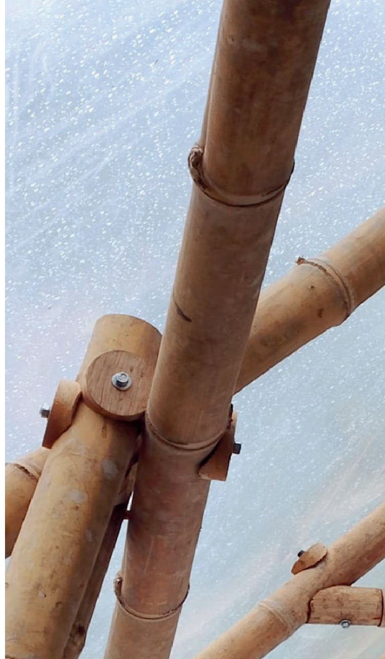
Foto No. 01. Conexión estructural de bambú con disco de contacto
